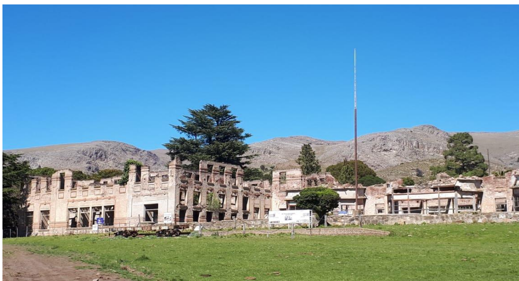
Figura 6. Ruinas del Club Hotel.
