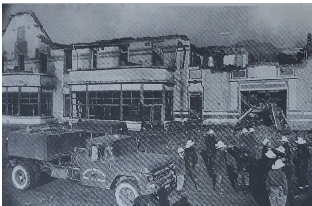
Figura 5. Bomberos trabajando en el incendio de 1983.
